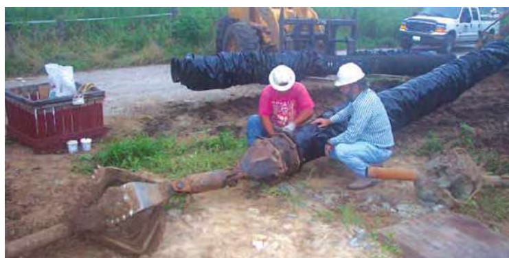
شکل ۳-۲۹-۷- نصب لوله به راد
