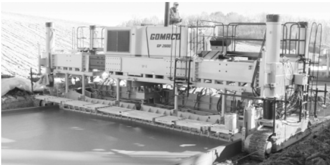
شکل ۴-۱۶-۶- فینیشسر قالب متحرک در حال اجرای روکش بتنی
