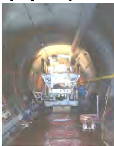
شکل ۳-۲۲-۲- نمایش ماشین نصب شده داخل تونل
