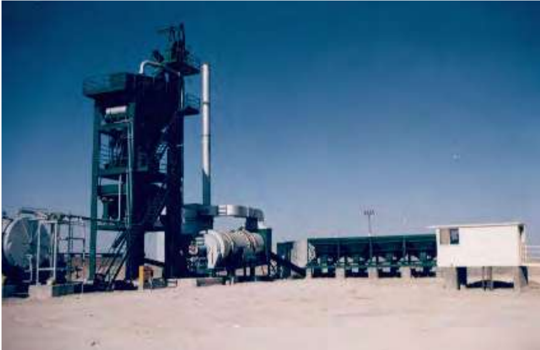
شکل شماره ۲-۲۱-۱- کارخانه آسفالت
