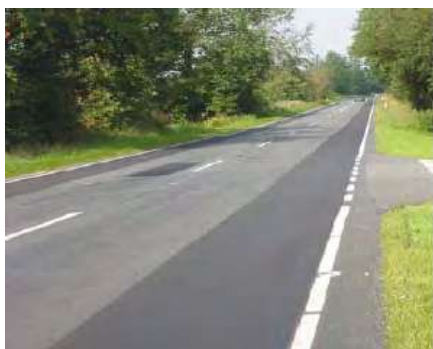
شکل شماره ۲-۲۰-۳- لکه گیری جاده ها
