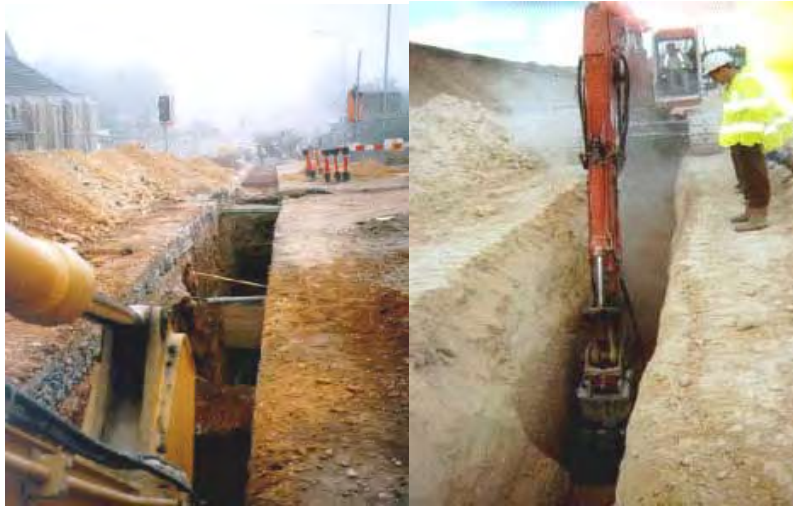
شکل ۳-۵-۳- کاربرد باکت حفار در حفر ترانشه
