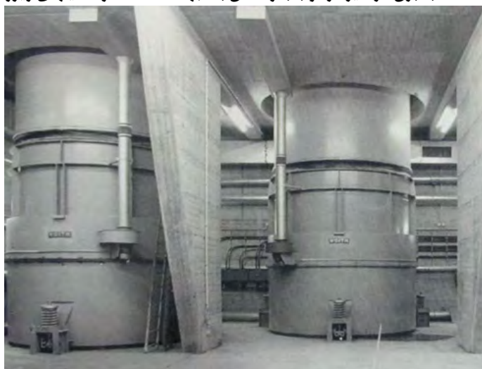
شکل ۶-۱۴-۹- بادبزن محوری قائم در تونل Elbe آلمان
