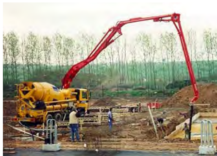
شکل ۴-۹-۸- پمپ بتن سوار شده روی تراک میکسر
