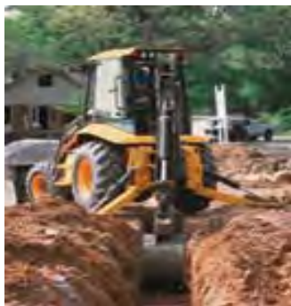
شکل شماره ۹-۲-۲- حفر کانال توسط بکهولودر
