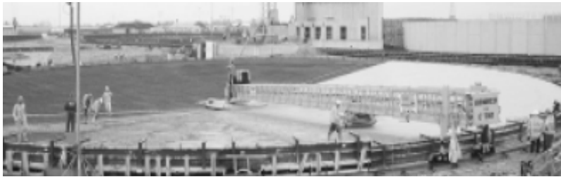
شکل ۴-۱۶-۵- استفاده از فینیشرسیلندری برای اجرای سطح دایروی
