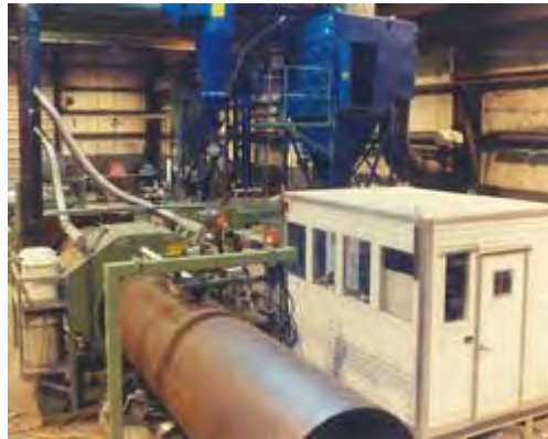
شکل ۵-۴-۷- کارگاه پوشش دهی
