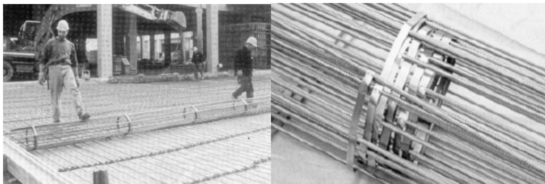
شکل ۴-۱۲-۱۳- تهیه آرماتورها به صورت فرش مانند و پهن کردن آن روی دال مورد نظر
