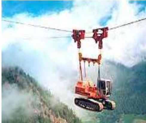
شکل ۶-۶-۱- جرثقیل کابلی در حال حمل بیل مکانیکی
