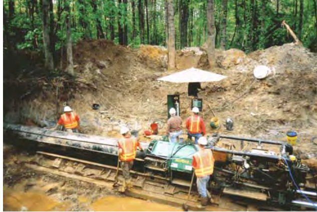
شکل ۳-۴-۷- استفاده از اوگر برای حفاری افقی
