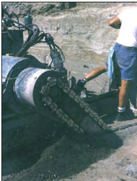
شکل ۳-۲۷-۱۳- نمونه ماشین هاواژ که به‌صورت خشک کار می‌کند
