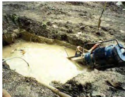
شکل ۳-۲۹-۵- گل حفاری در حال خروج از چال
