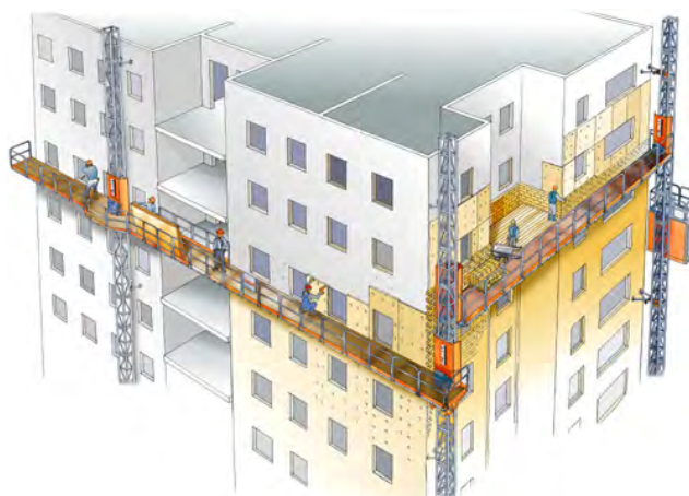
شکل ۶-۱۰-۷- استفاده از mast climbing در نقاشی نمای سازه
