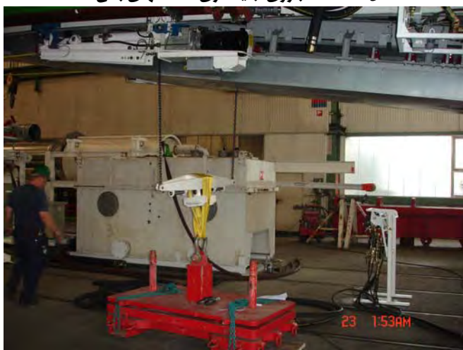
شکل ۳-۳-۲۴. جرثقیل ۲۰ تن حمل سگمنت بتنی
