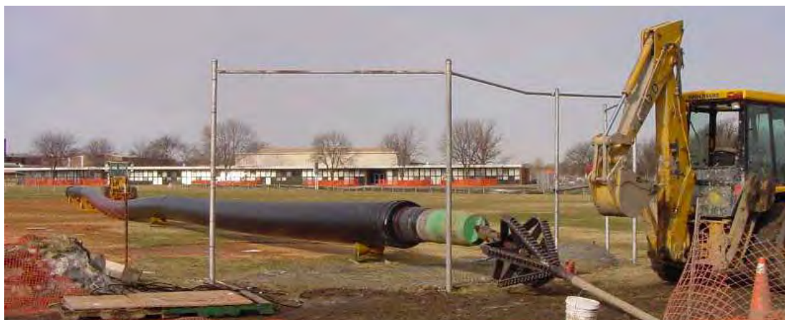
شکل ۳-۲۹-۸- لوله متصل به راد و آماده کشش
