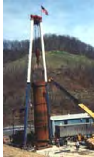
شکل ۳-۱۴-۵. نمایی از کیسینگ فولادی و قرار دادن آن در چاه
