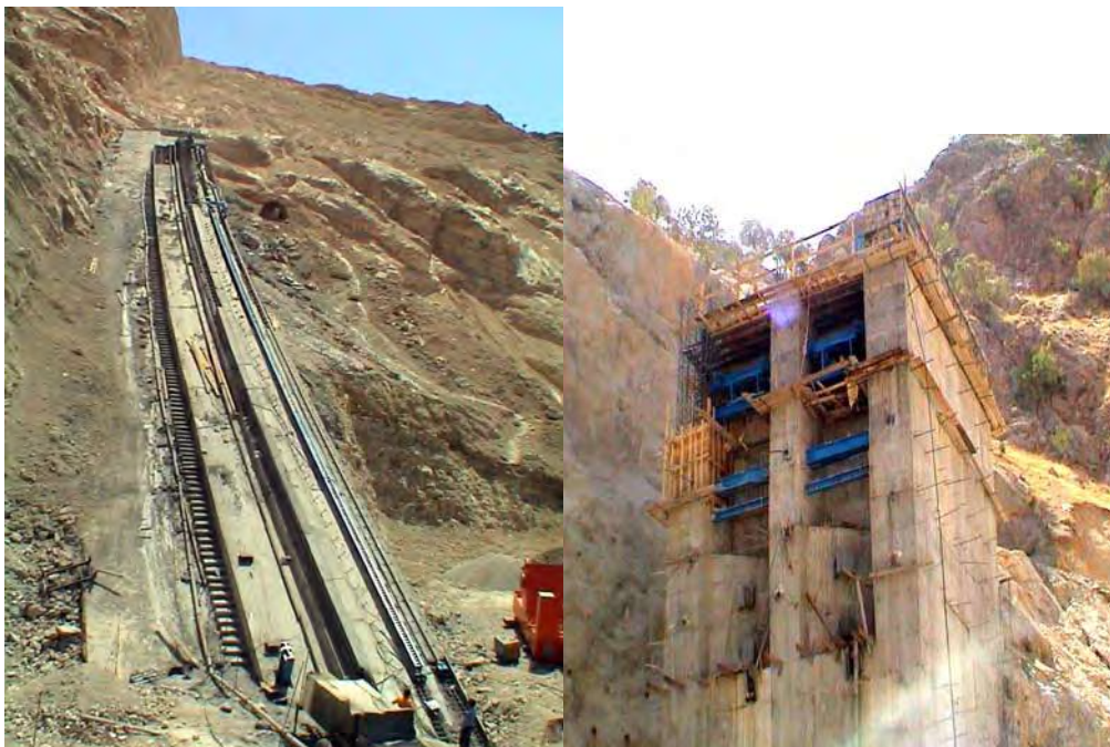
شکل شماره ۶-۶-۶- پایه ثابت جرثقیل یک سر ثابت و ریل شعاعی آن
