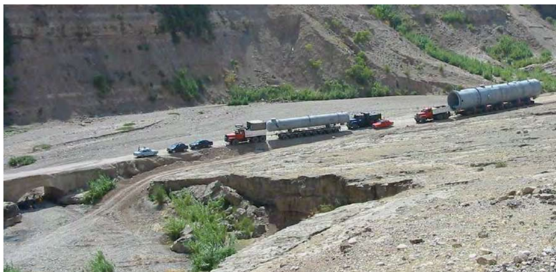
شکل ۶-۲-۱۰- عبور بوژی از کنار گذر پل
