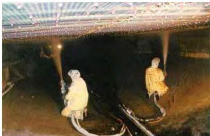
شکل ۴-۱۸-۱- نمایشی از کاربرد شاتکریت
