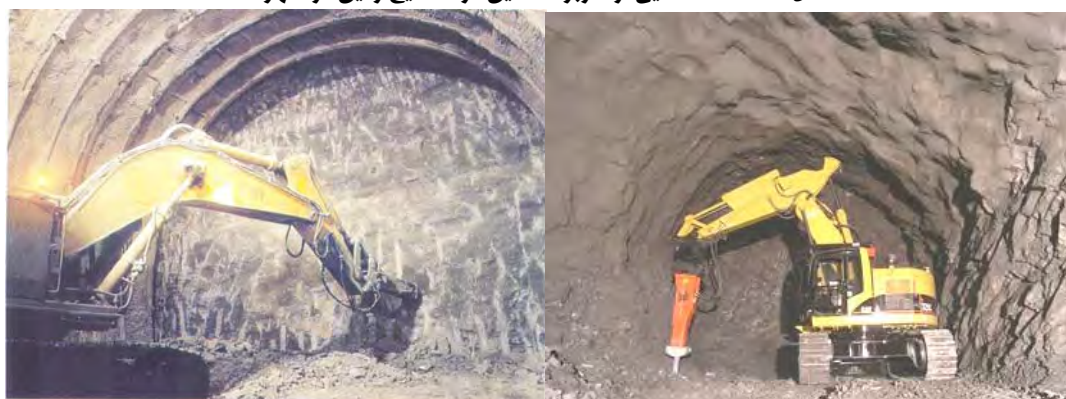
شکل ۳-۱۰-۸- نمایی از کاربرد ماشین در حفاری و لقی گیری تونل
