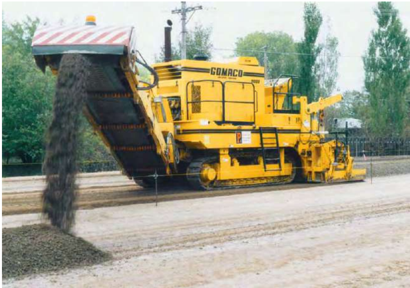
شکل شماره ۲-۱۸-۳- تسمه نقاله تریمر آسفالتی
