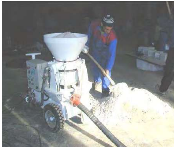
شکل ۴-۱۸-۴- نحوه ریختن مصالح در دستگاه پمپ شاتکریت
