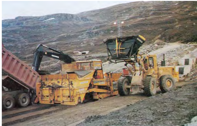
شکل ۲-۱۷-۴- بارگیری ماشین پخش مصالح سد هسته آسفالتی
