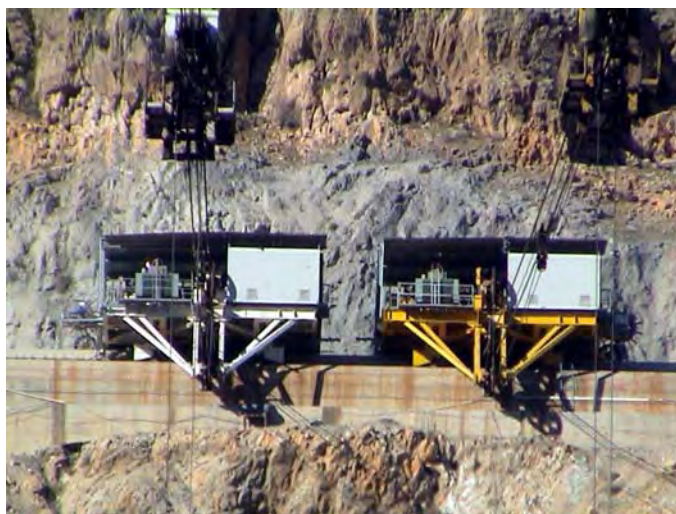
شکل شماره ۶-۶-۴- نمایی نزدیک از واگن‌های اصلی سیار جرثقیل کابلی موازی کارون ۳ (جناح راست)
