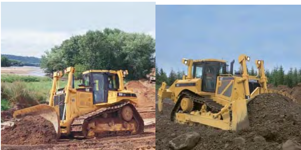
شکل شماره ۲-۲-۱- بولدوزر در حین عملیات خاکی
