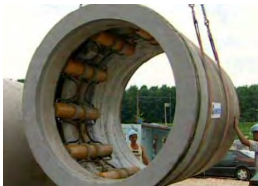
شکل ۵-۱۰-۴- لوله بتنی مخصوص عملیات لوله رانی
