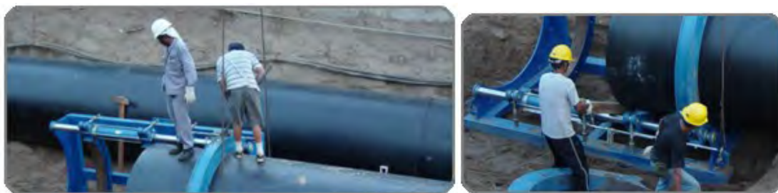
شکل ۵-۹-۳-الف) جوش لب به لب در لوله سایز بزرگ
