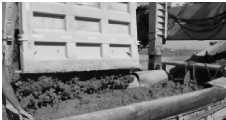
شکل ۴-۱۶-۷- تخلیه بتن در مخزن تسمه نقاله
