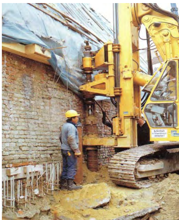
شکل ۳-۴-۱۰- حفاری با اوگر در مجاورت دیوار
