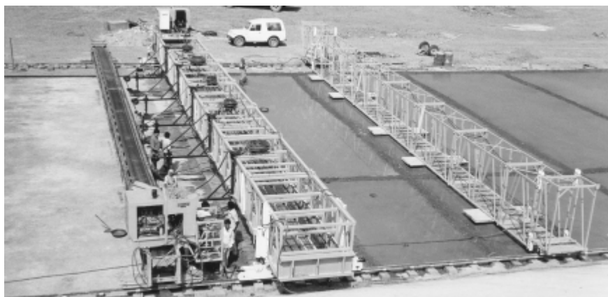
شکل ۴-۱۶-۳- استفاده از یک فینیشر در کنار تجهیزات پخش و پرداخت سطح بتن
