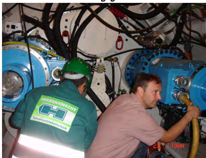
شکل ۳-۳-۳۷. فضای داخلی اتاقک جلویی کلگی. در تصویر موتورهای نصب شده دیده می‌شود.
