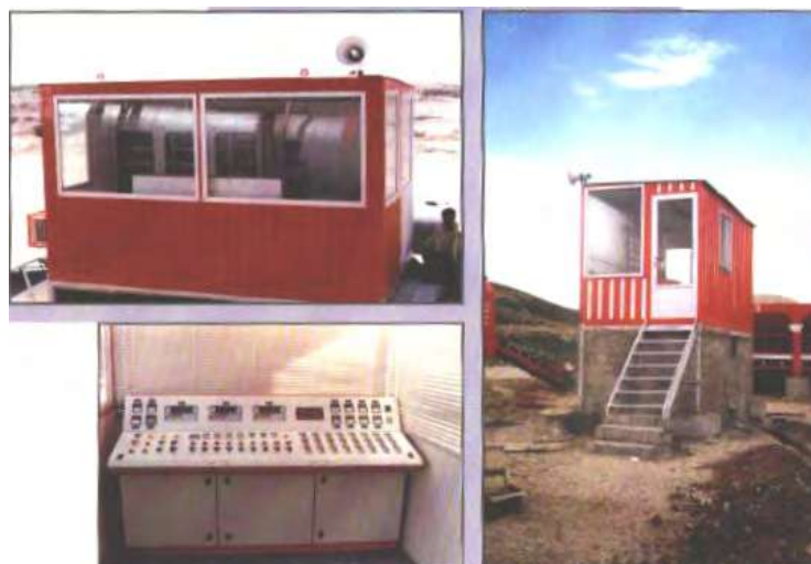
شکل شماره ۲-۲۱-۱۴- اتاق فرمان
