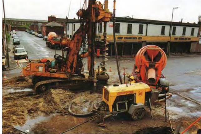
شکل ۳-۴-۵- تزریق بتن به درون چال از درون اوگر
