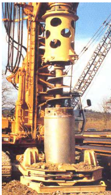
شکل ۳-۴-۸- اوگر با لرزاننده لوله
