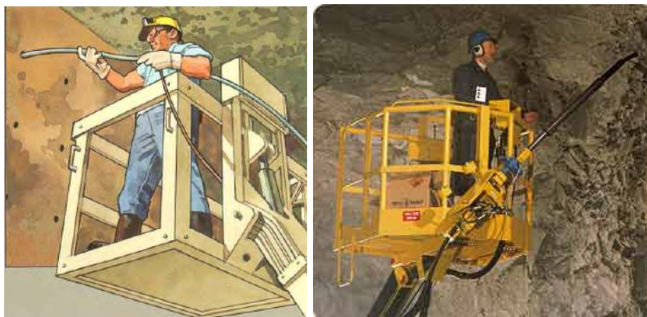
شکل ۳-۲۸-۱۱ خرجگذاری از داخل سبد دستگاه آنفوشارژر
