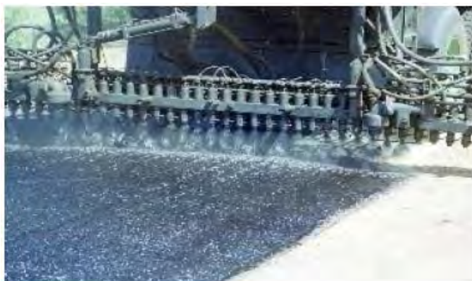
شکل شماره ۲-۲۰-۹- لوله پخش (spray bar)
