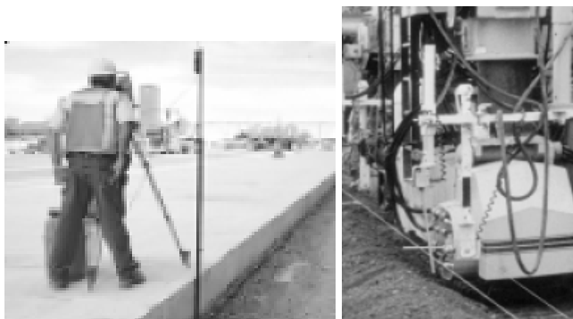
شکل ۴-۱۶-۱۱- کنترل مسیر بوسیله ریسمان و یا به صورت الکترونیکی (دو روش مختلف)
