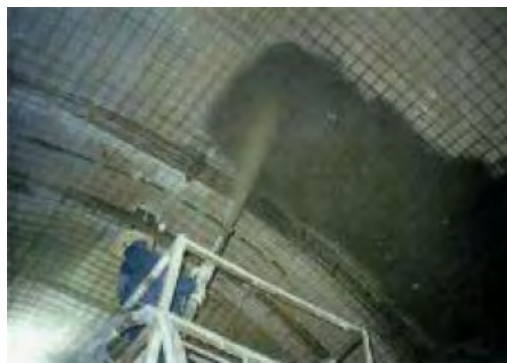
شکل ۴-۱۸-۲- استفاده از شاتکریت برای نگهداری فضاهای زیرزمینی
