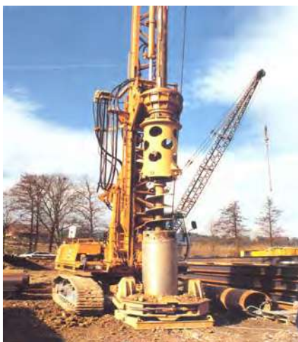
شکل ۳-۴-۶- استفاده از اوگر برای حفاری قایم
